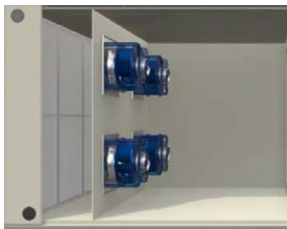
Rys. 1. Wizualizacja modernizacji wentylatorów z przekładnią pasową.
